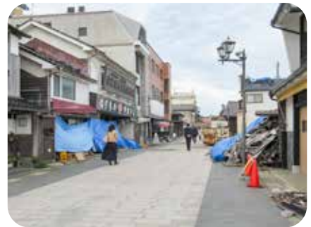
輪島朝市通りでは崩れたままの家屋も
