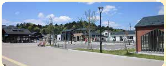
震災後、高台に移設された JR 仙石線野蒜駅。広場のすぐ先に観光物産交流センターや市民センターがあります。
