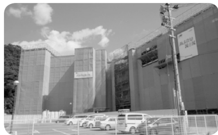
▲石巻の市街地では復興公営住宅の建設が進むが計画戸数3,250戸（半島部を除く）のうち入居できているのは149戸にすぎない。
