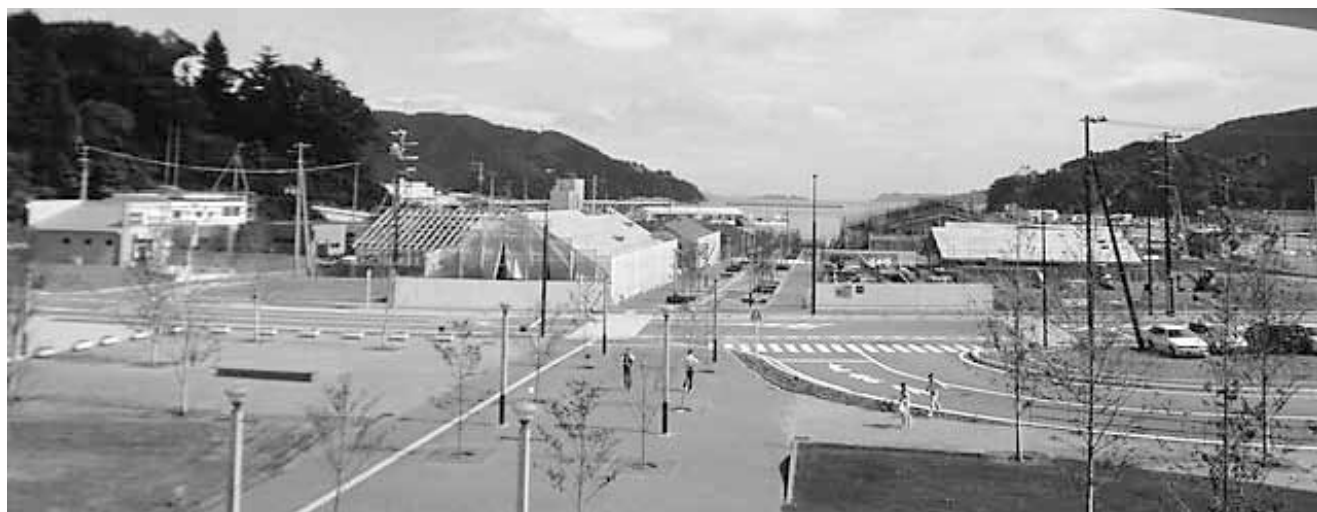
▲商店街の建設工事が進む駅前プロムナード。湾左手には女川魚市場や水産加工団地が並ぶ。
